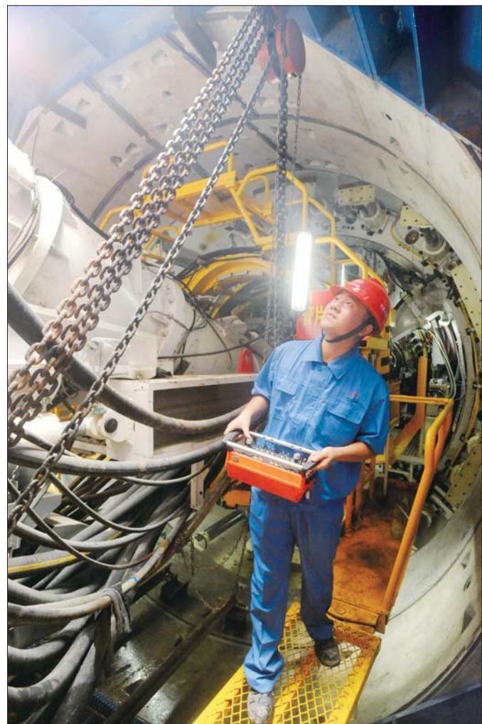
首台盾构机机长陶春雨正在遥控操作。本报记者 左庆 摄
