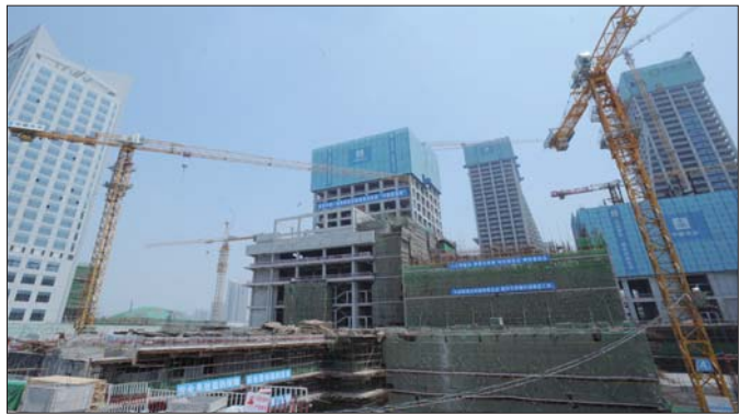
今年4月,济南中弘广场正在高速建设。(资料片) 本报记者 戴伟 摄
