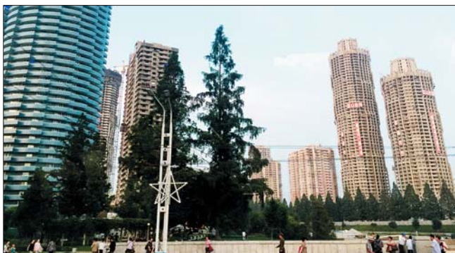
平壤正在建设中的住宅。
