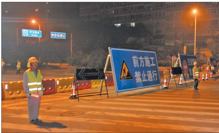
开元隧道在2014年曾进行过穹顶漏水改造。施工方供图
