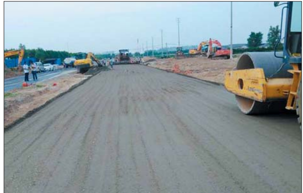
滨河路南延进行道路整修。
