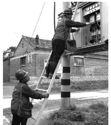
雨后抢修保供电
