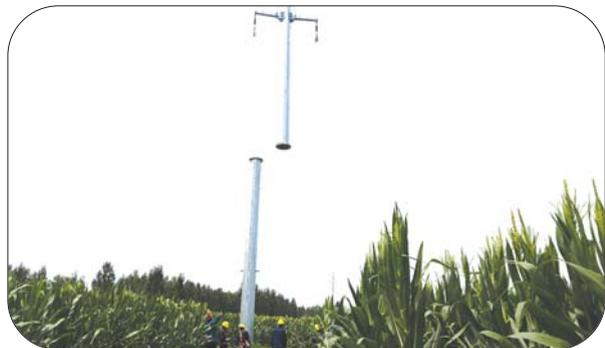
施工人员用吊车安装管塔。
