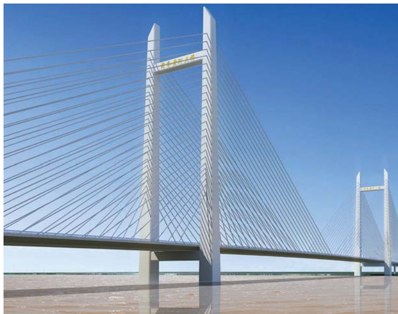
齐河县规划实施了10大类、104项城乡基础设施建设工程，综合承载力不断提升。图为建设中的济齐黄河大桥，是山东省重点建设项目。
