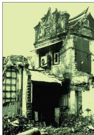
高都司巷拆除时旧景。
