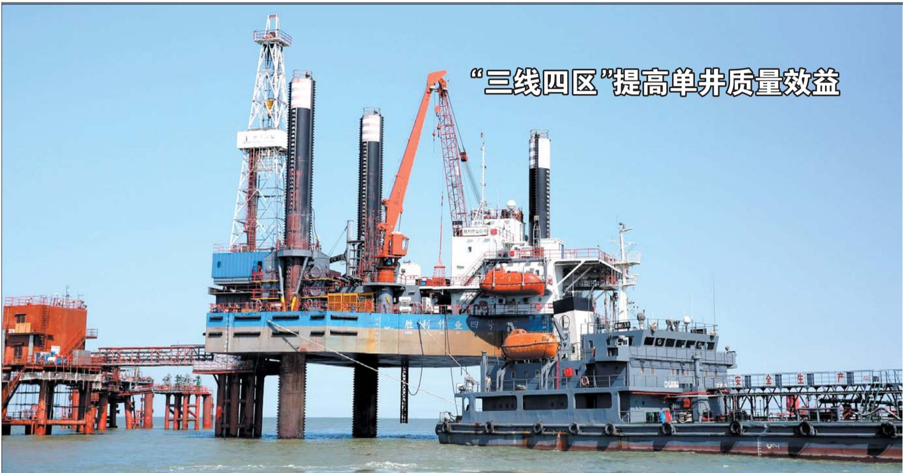
今年以来,胜利油田海洋采油厂海一采油管理区围绕老井挖潜、低液井治理、控水稳油等重点难点工作,利用“三线四区”经济运行模型找寻老区效益开发“突破口”。在组织全员开展单井效益分析活动中,海一管理区对处于低效区、无效区的油井进行讨论研究,通过措施作业、调参、解堵等措施,努力提高油井生产效益。图为胜利井下作业公司作业四号平台正在对CB11H-4井实施拔滤、防砂、补孔措施作业。
