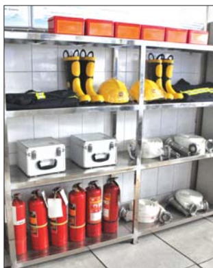
医院的微型消防站。
