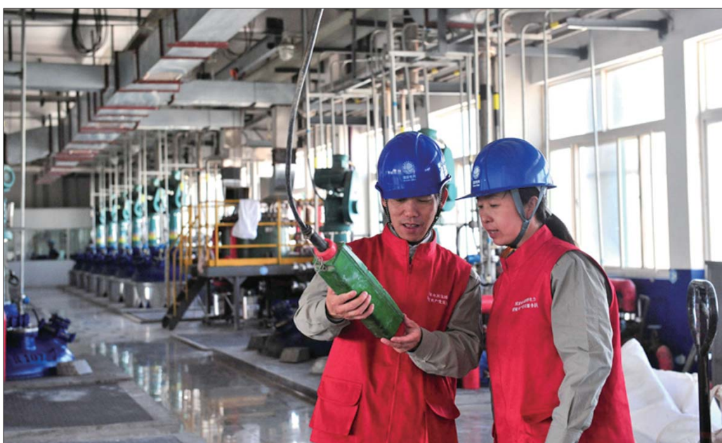
国网淄博供电公司到企业保障用电安全。
