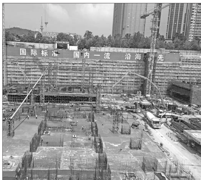
施工现场, 工人在深达30多米的基坑里作业。
