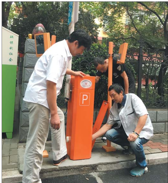
物业工作人员正在维修刚刚坏掉的道闸系统。
