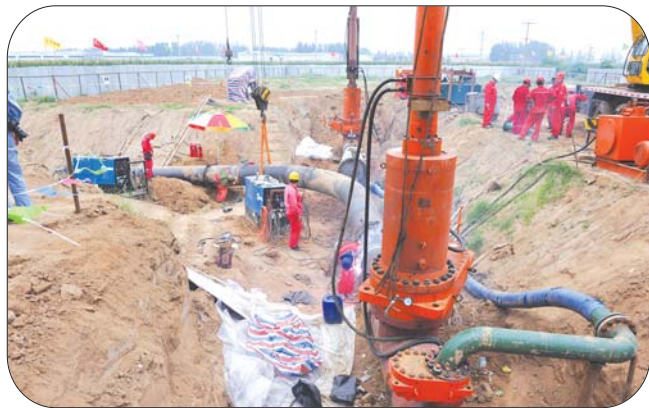
滕州改线段施工现场。
