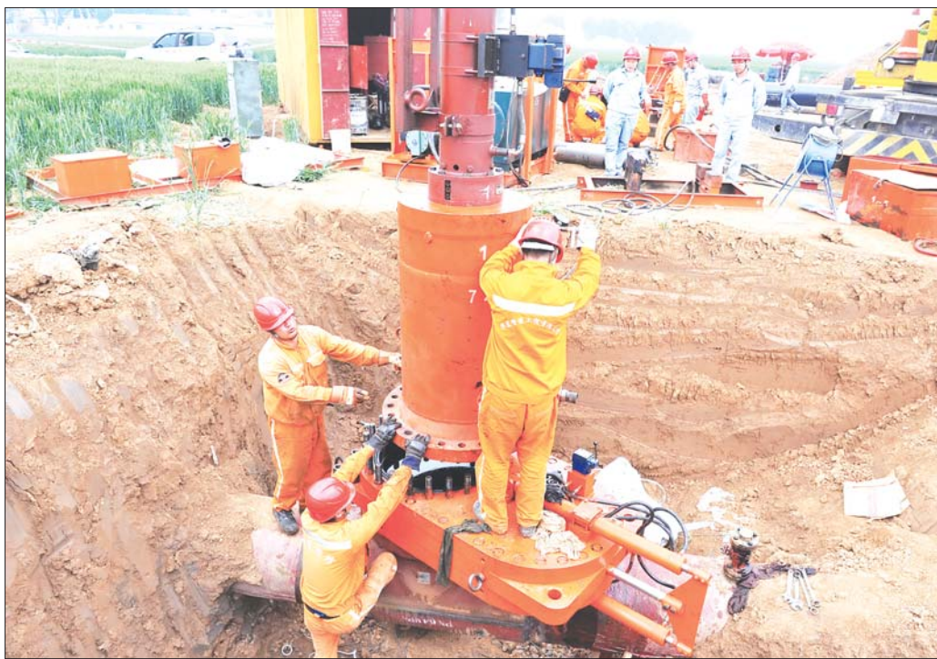
泗河段改线工程现场。
