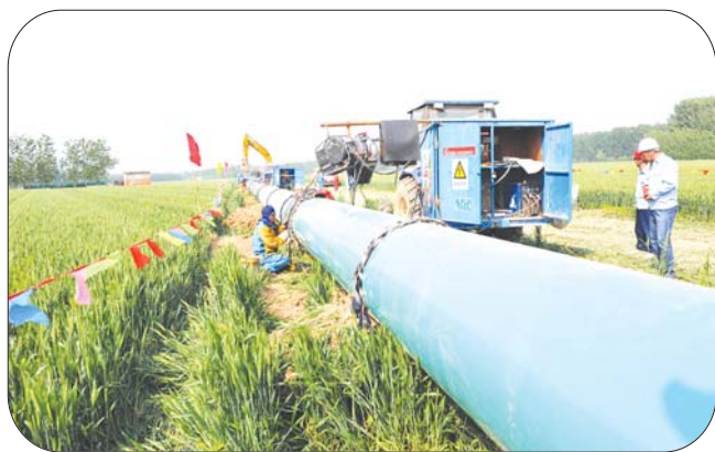
鲁宁管道改线工程肥城段施工现场。
