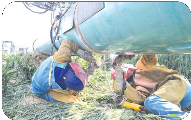
工人正在紧张施工。
