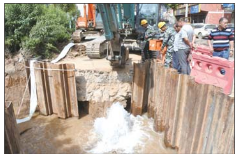
施工人员正在给老管网排水。本报记者 蒋龙龙 摄
