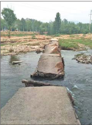
被雨水冲坏的北大沙河桥。
