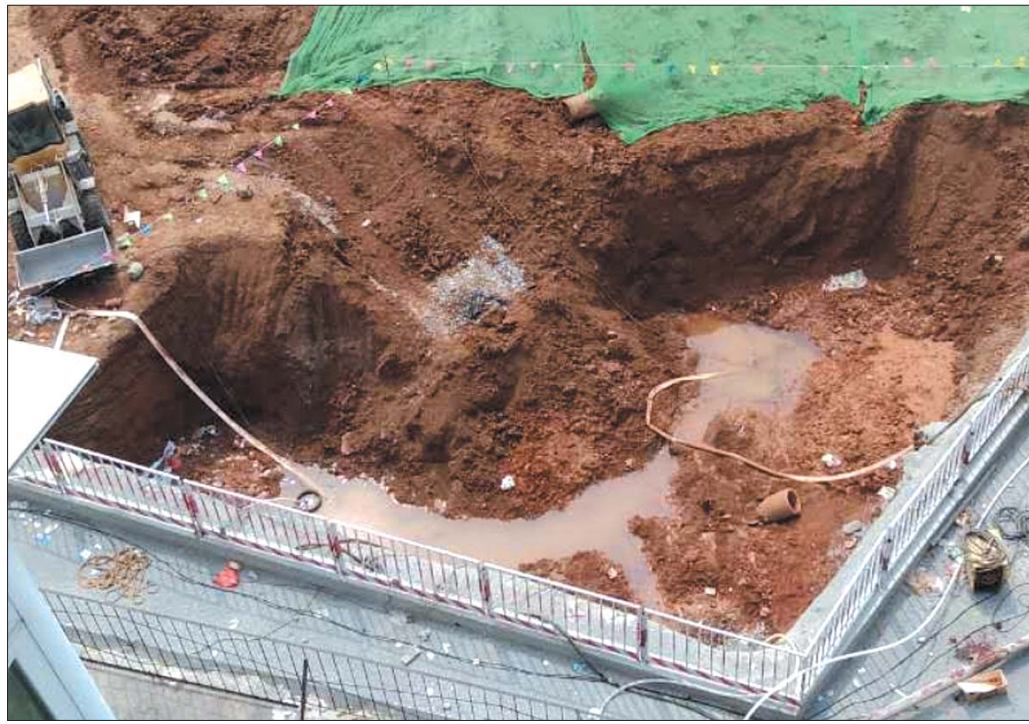
5日下午4点记者在现场看到,水泵一直在抽取大坑里的水。 本报记者 孙业文 摄
