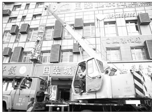
城管执法人员拆除违规楼宇广告牌。
