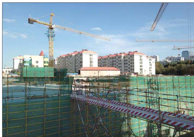
正在建设的青龙河净水厂身处闹市。本报记者 张玉岩 摄
