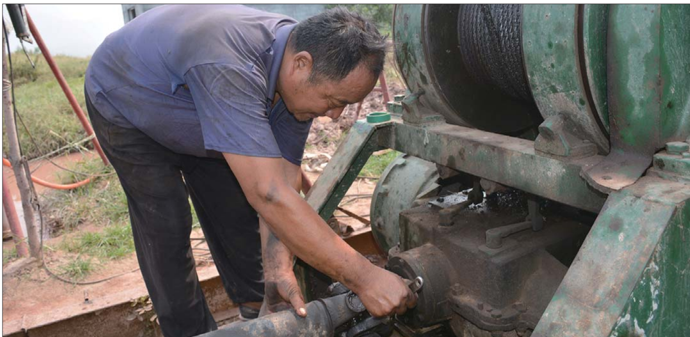
认真维修打井机械。
