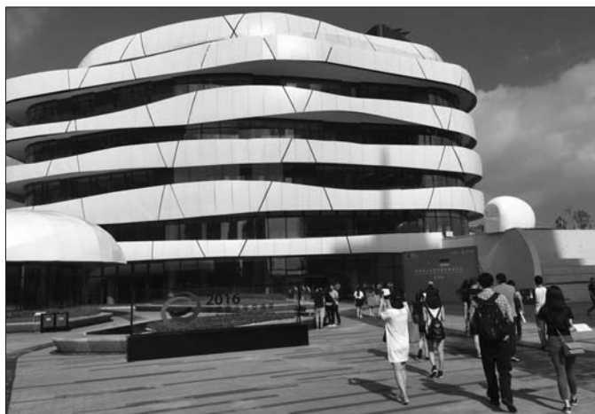
青岛中德生态园被动房技术体验中心。
