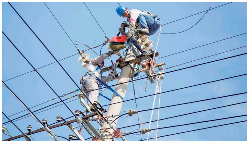
9月21、22日,荣成公司对35千伏埠柳站1号主变301开关及CT、2号主变302开关及CT,以及35kV港埠线312开关及CT开展更换工作,并利用站内停电时机,完成该站2条10钱千伏线路检修工作。
