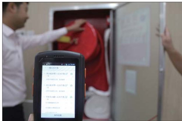
扫描二维码后,手机上出现需要巡查的消防器材的信息。
