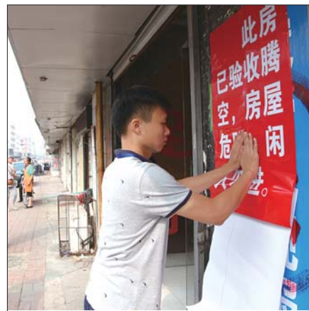
拆迁同时,工作人员也跟紧完成验收,确保拆迁工作能在最短时间内完成。 本报记者 林媛媛 摄
