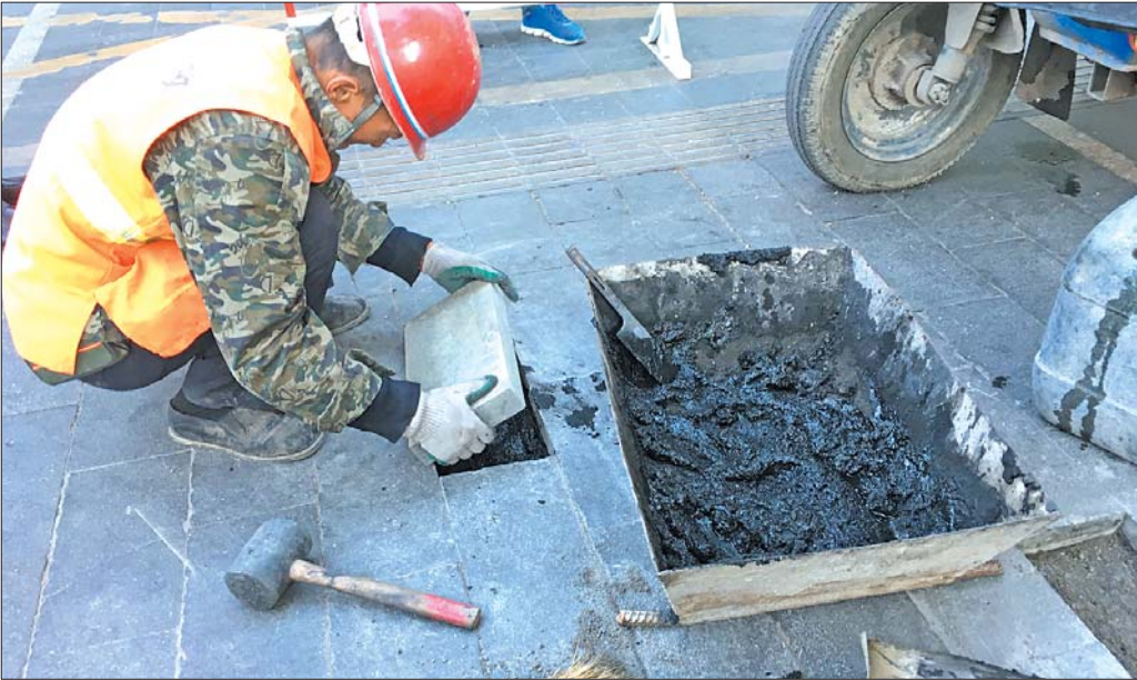
维护人员正在更换路面破损的大理石砖。 本报记者 王皇 摄
