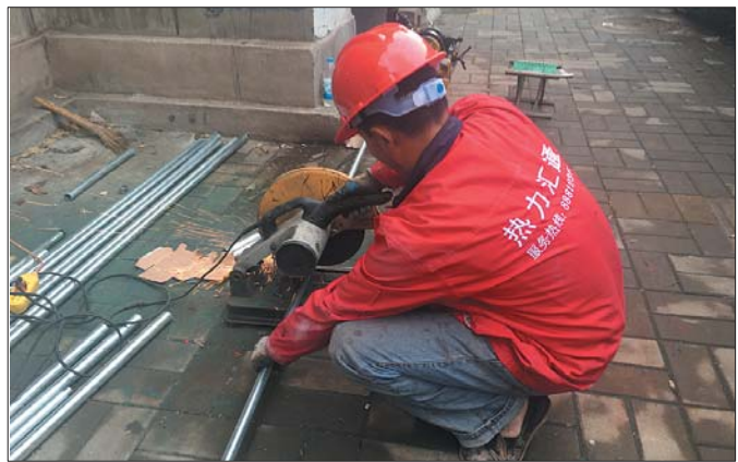
济南热力公司工作人员正在安装供暖设施。
