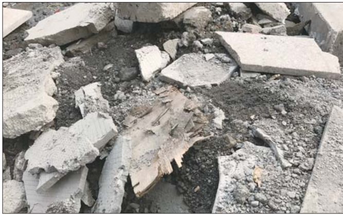
住户家中的水泥地面被撬开后露出了里边的填充物。
