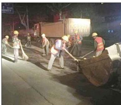
工作人员对撒漏的渣土进行清理。 天桥交警供图
