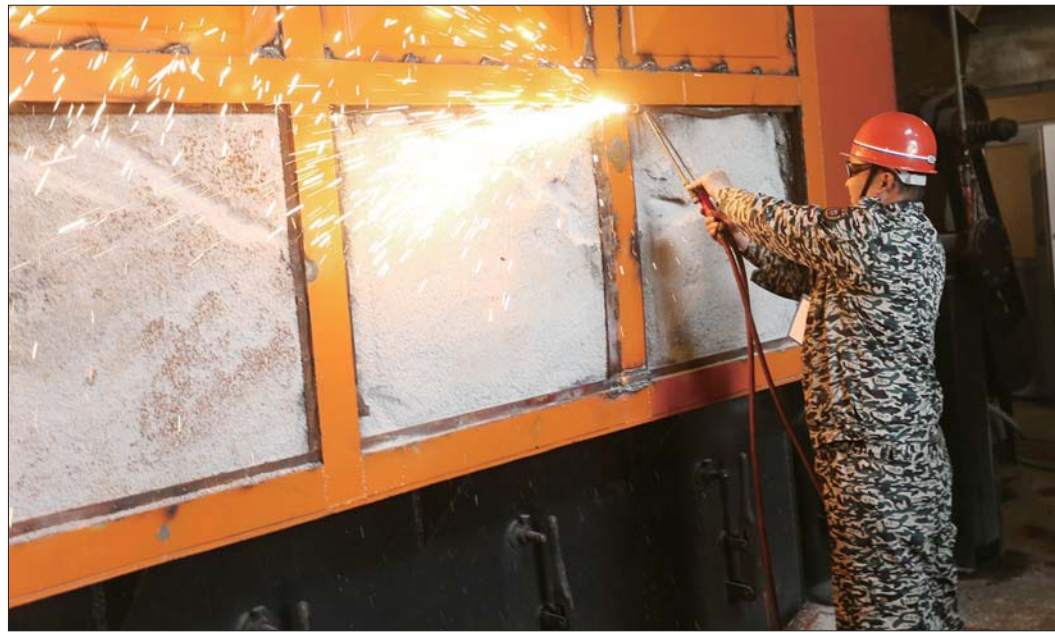
济南热企工作人员拆除燃煤锅炉房。(资料片) 本报记者 蒋龙龙 摄
