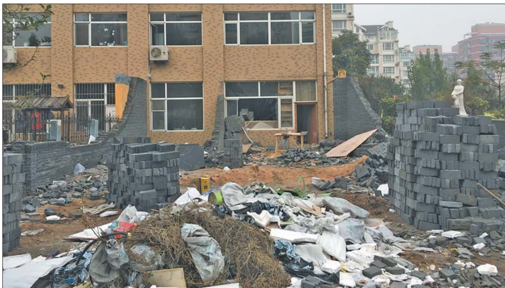
联排别墅前最东户的围墙被拆除。
