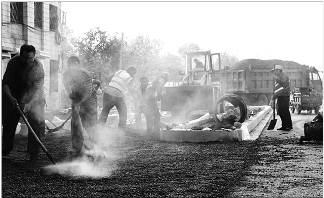
济邹路升级改造工程施工现场(资料图)。
