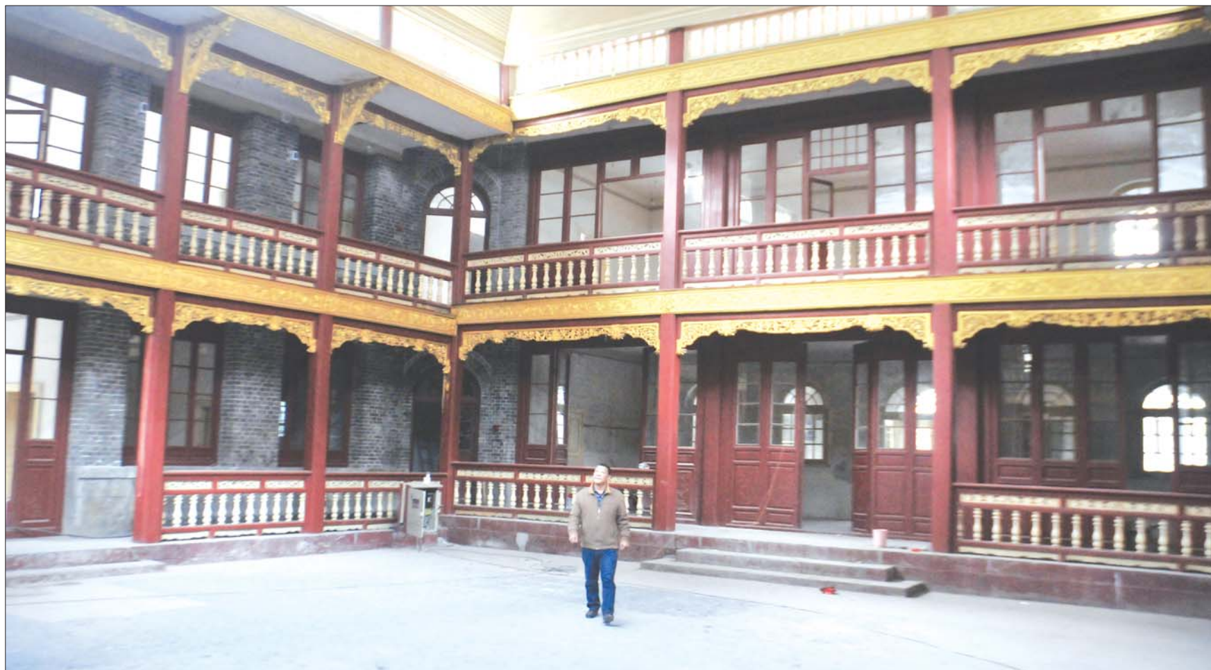
整修一新的潘家大楼内部楼体。
