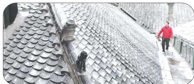
楼顶更换了仿古瓦片。
