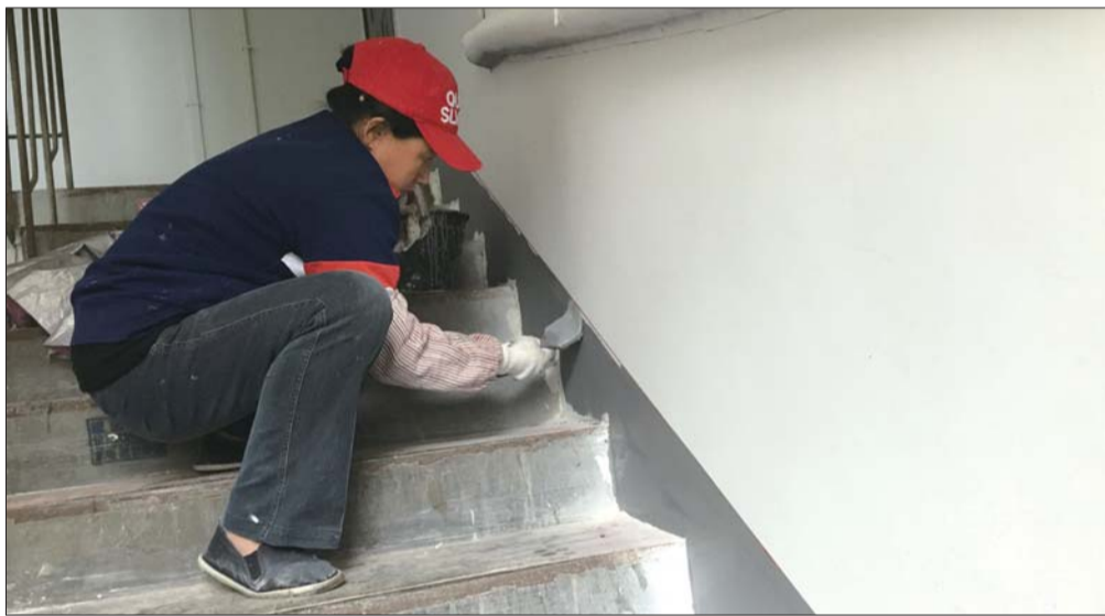
施工人员整修楼道踢脚线。本报记者孟杰摄
