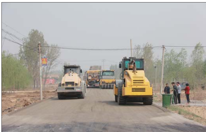
施工中的桥王路。
