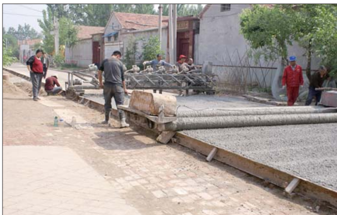
贫困村道路施工现场。
