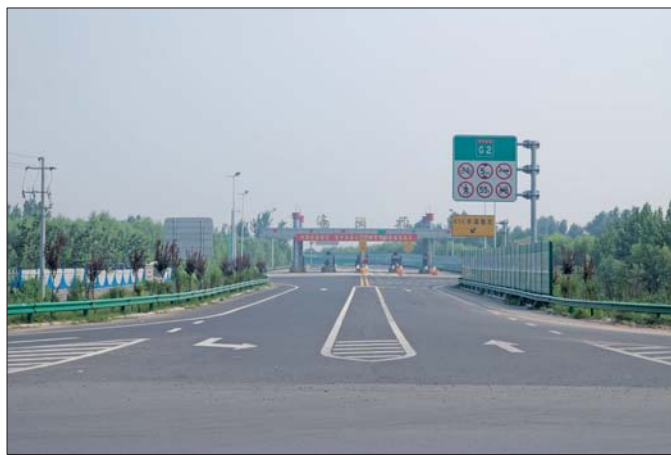
济乐高速济阳(西)出入口太平镇后石村附近。
