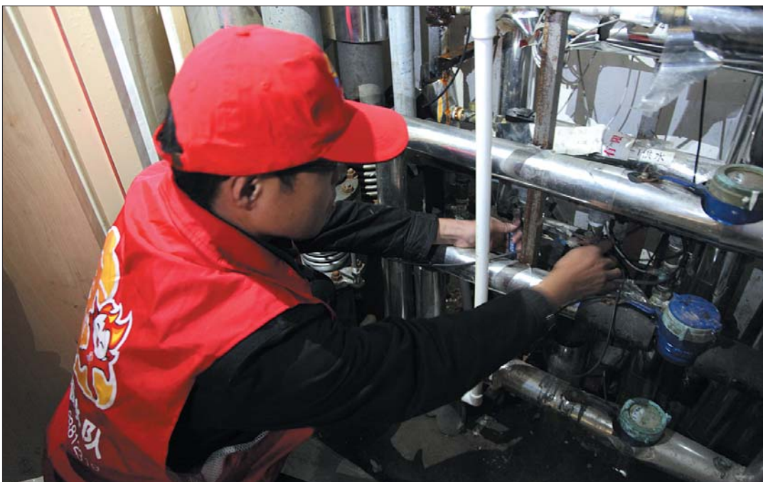
济南热力公司工作人员在清洗供暖设施过滤阀。 本报记者 蒋龙龙 摄
