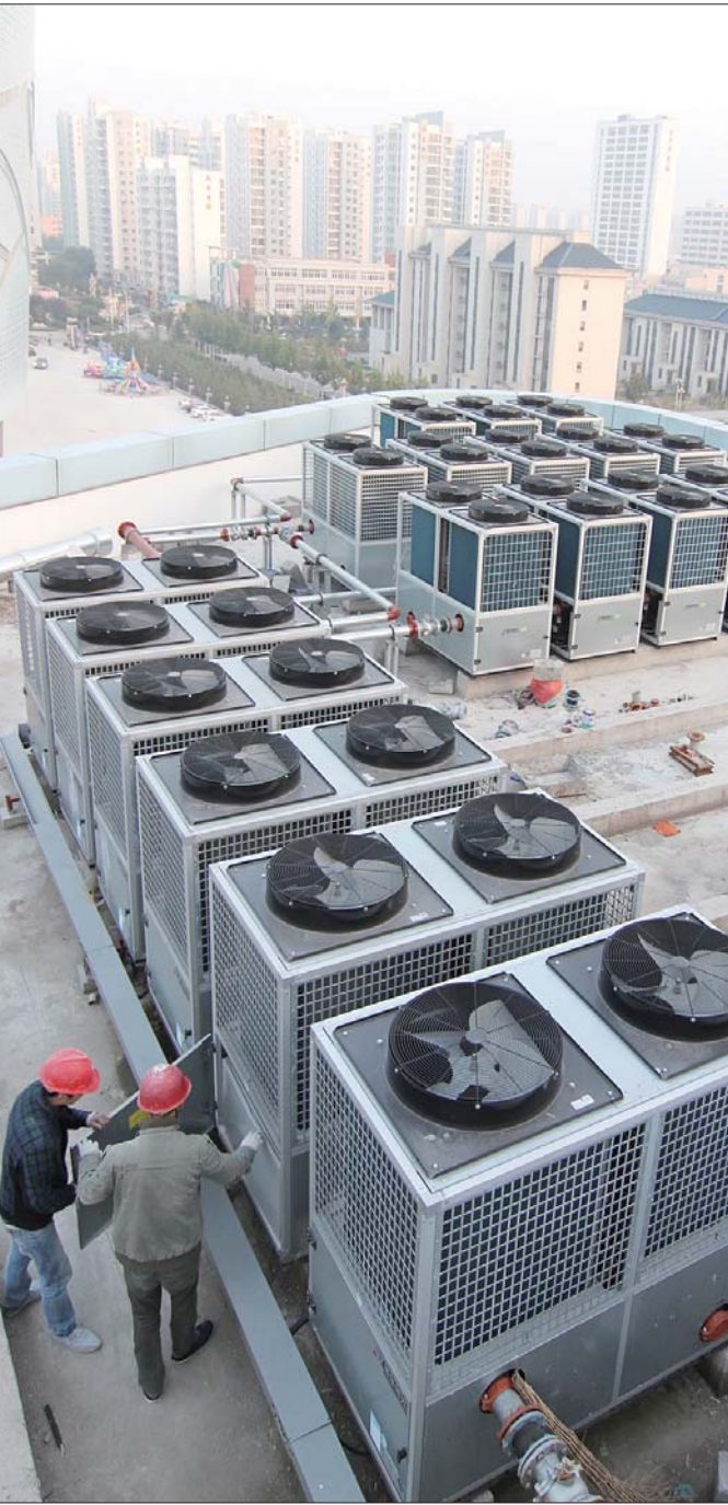
在临沂齐鲁园广场小区,工作人员正在对空气能热泵主机进行检查。
