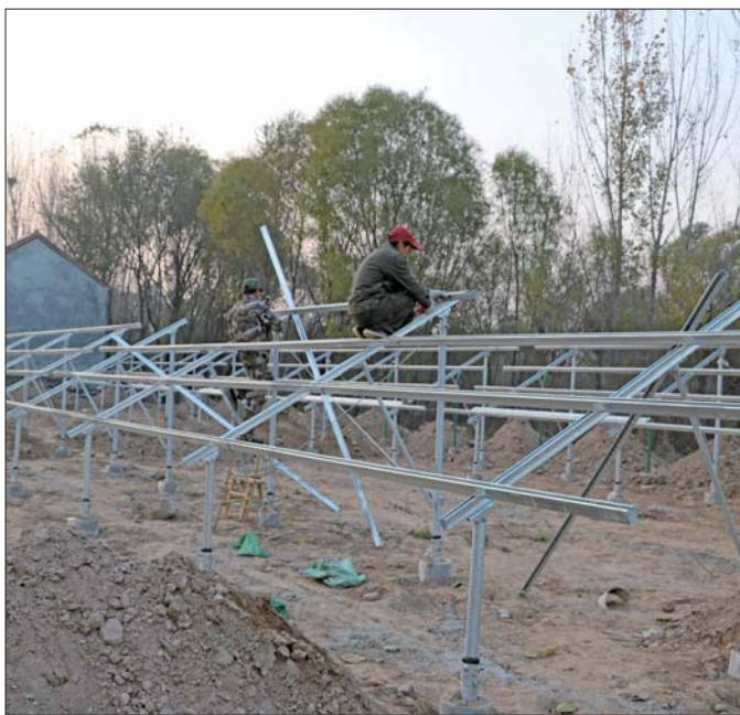
赵家村光伏发电项目施工现场。杨翠萍 供图
