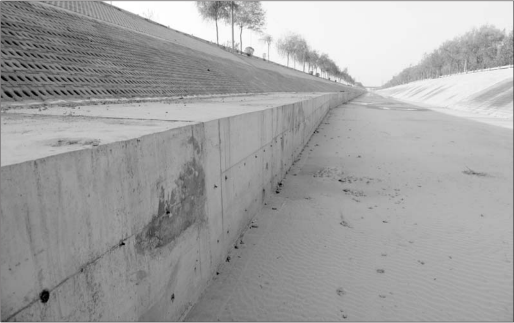
阳河广饶段,河道左侧高约1.5米、宽两米的箱涵将上游青州来水直接送到下游寿光。 本报记者 孙国祥 摄
