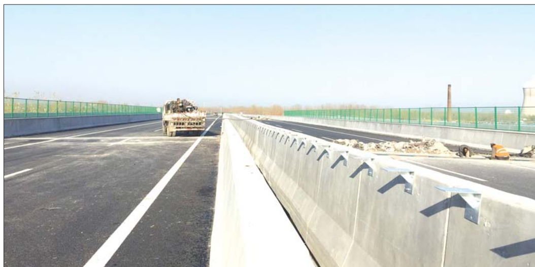
济徐高速公路主线工程基本完成,目前正进行收尾工程。本报记者 庄子帆 摄
