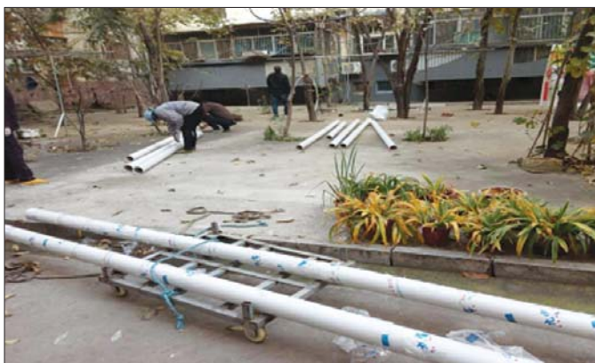
居民说事会议开过后,落水管得到维修。
