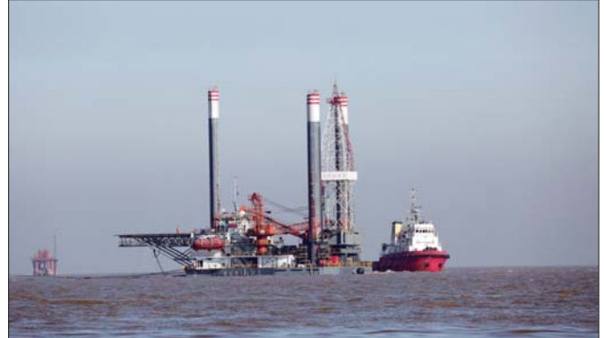
正在托航移动式作业平台。 本报通讯员 王振国 摄
