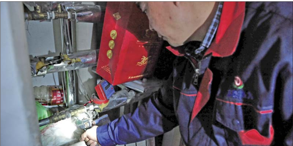
东泰热力公司工作人员在清洗过滤网,提高居民室内温度。 本报记者 周青先 摄
