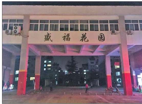
房产证下不来,盛福花园小区居民开始维权。(居民供图)
