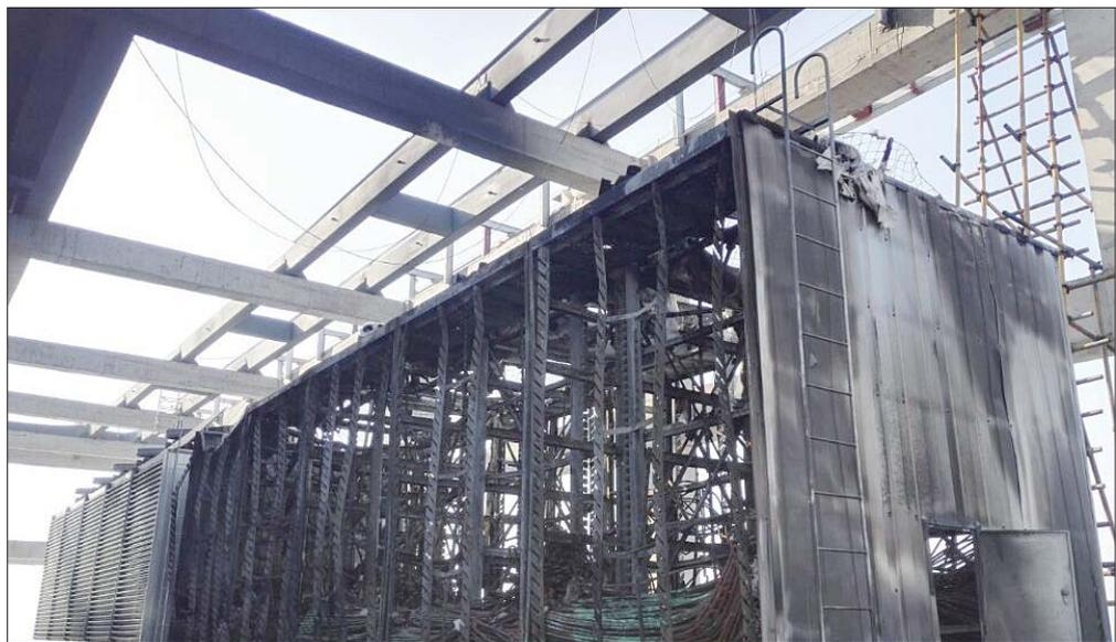
冷却塔已被烧得焦黑变形。
