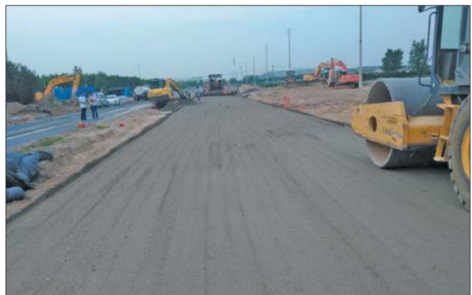
道路改造工程施工现场。
