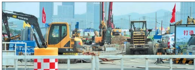
R3线首台盾构机明年5月入地
