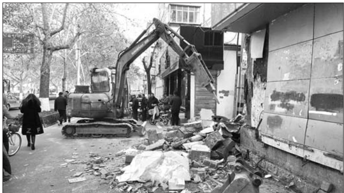
历山路沿线的违章建筑已经被拆除。 本报记者 周青先 摄
