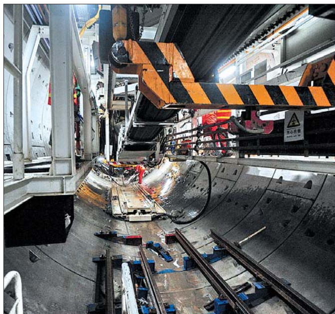
R1线地下盾构机施工。 本报记者 周青先 摄
